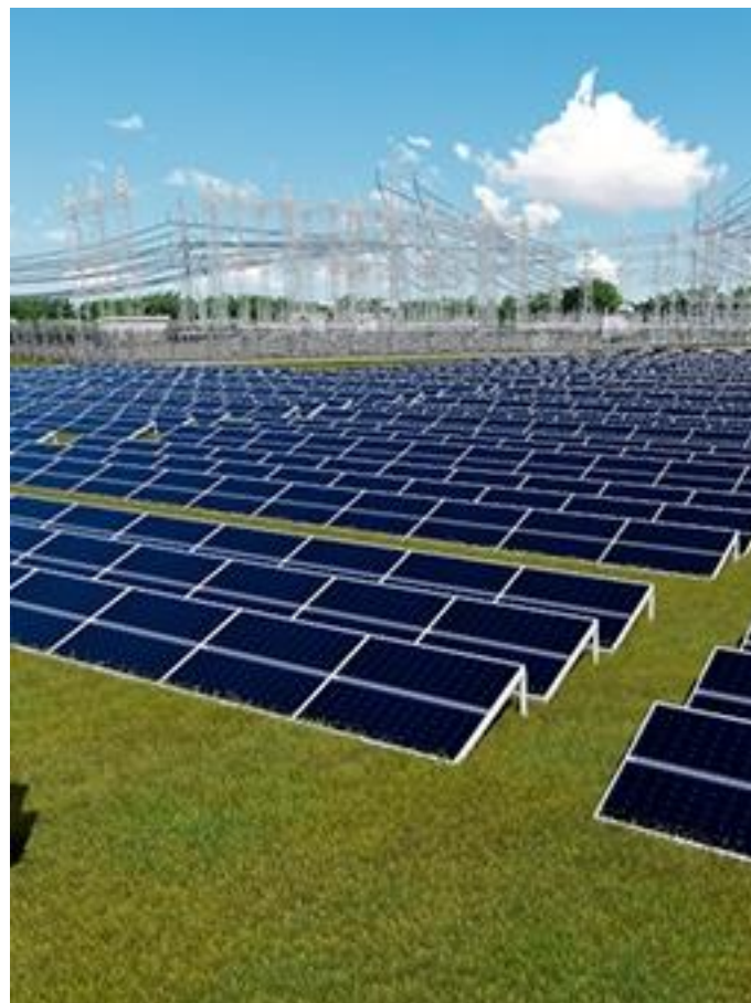
Ubicación de los paneles solares de la granja/ Fuente: http://www.celsia.com/Portals/0/EasyDNNnews/2262/Celsia_250.jpg
