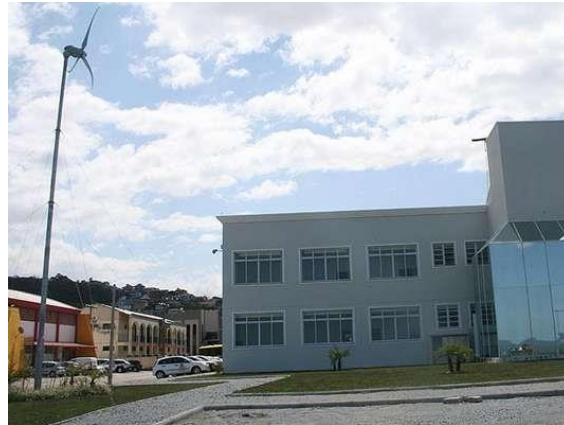
Aerogenerador instalado em el Ayuntamiento.
