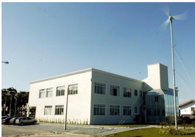
Edificio del Ayuntamiento de São José
