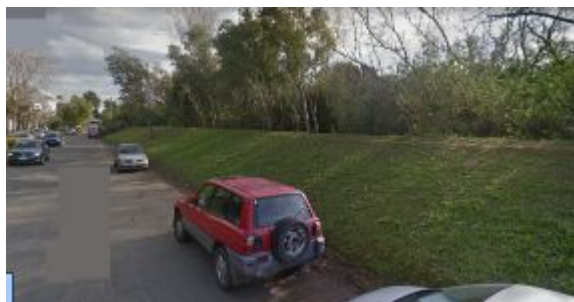
Imagem da ravina vista da rua Camino de la Ribera Norte no auge da estação de Las Barrancas. Fonte: Google StreetView, imagem de junho de 2017.
