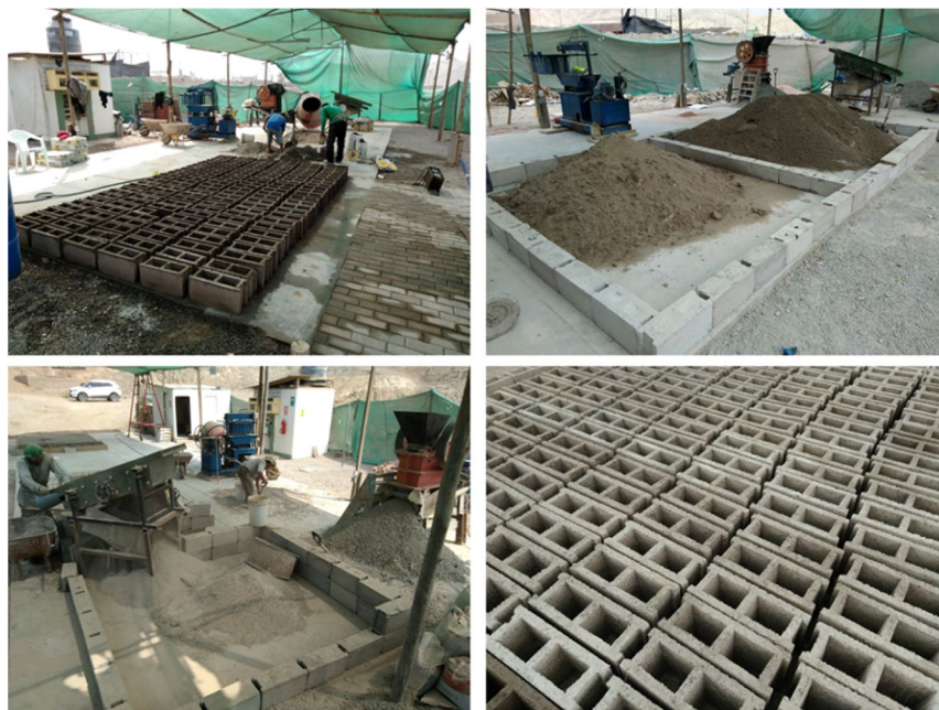
Fabricación de productos de construcción reciclados en la planta piloto, Cieneguilla, Lima. Fuente: CICLO.
