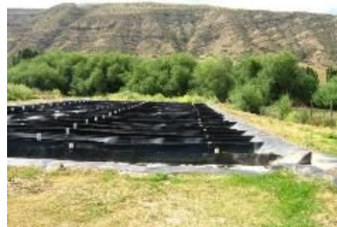
Canal impermeabilizado. Fuente: fotos propias de los autores.
