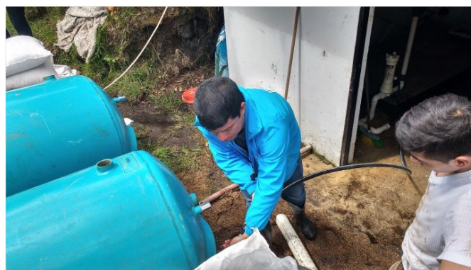
Acompanhamento para o fortalecimento dos aquedutos
