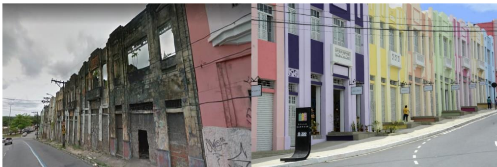
Villa Sanhauá: antes y después. Fuente: prefeitura municipal de João Pessoa
