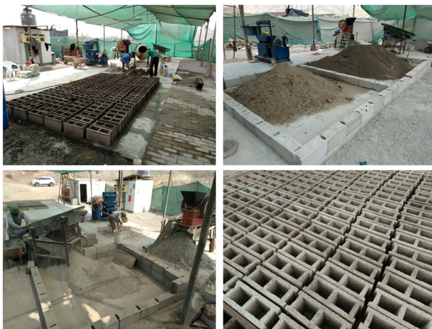
Fabricación de productos de construcción reciclados en la planta piloto, Cieneguilla, Lima. Fuente: CICLO.
