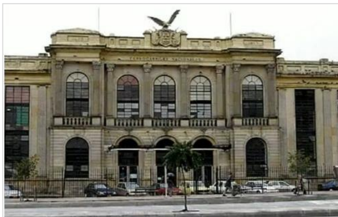
Estación tren de la Sabana. Fuente: https://co.pinterest.com/pin/497929302526817964/?lp=true
