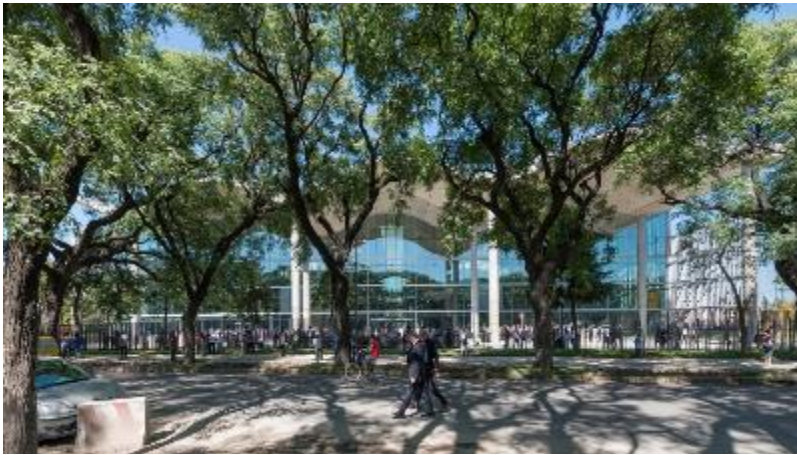
Vista exterior de la sede de gobierno. Fuente: sitio web Foster & Partners (fosterandpartners.com)
