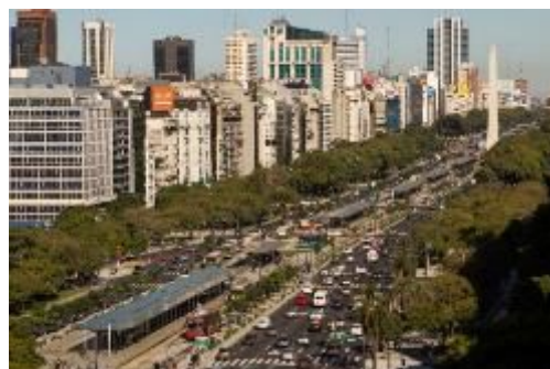
Vista do Centro de Transbordo da Av. 9 de Julio. Fonte: Governo da Cidade de Buenos Aires.
