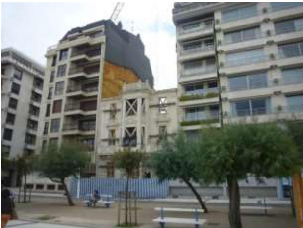
断熱材の設置・外壁面の保存
