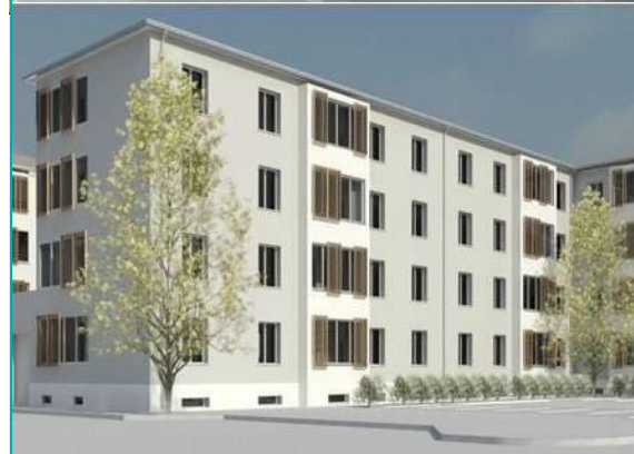
ACER 단지 내 건물의 복원 전 및 후 모습
