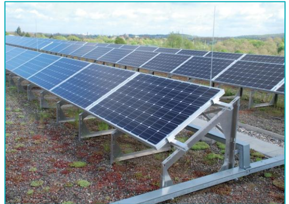
그린 루프와 태양광 발전 패널이 결합된 환경부 지붕
