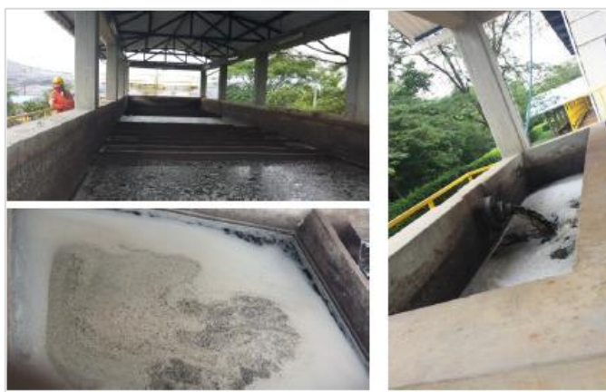
Tanques donde se llevan a cabo procesos primarios, de igualación y tratamiento de lixiviados/ Fuente: Poveda, F. (2015) Análisis del Plan Integral de Gestión de Residuos Sólidos "PGIRS", del municipio de Villavicencio, Departamento del Meta, en sus componentes: Implementación, Actualización, Seguimiento y Control. Facultad de Ciencias Contables, Económicas y Administrativas. Universidad de Manizales. Colombia p.118
