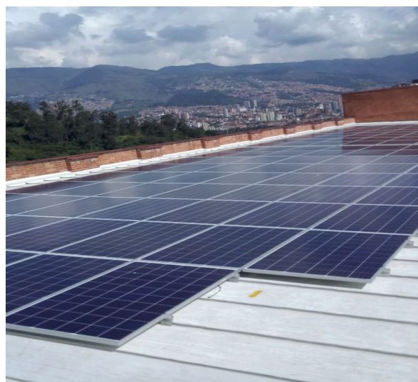
Painéis solares colocados na cobertura.
