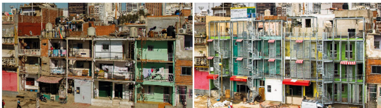
Melhorias feitas nas casas do Barrio 31 e 31 Bis, projeto, antes e depois. Fontesite do governo da cidade (buenosaires.gov.ar)
