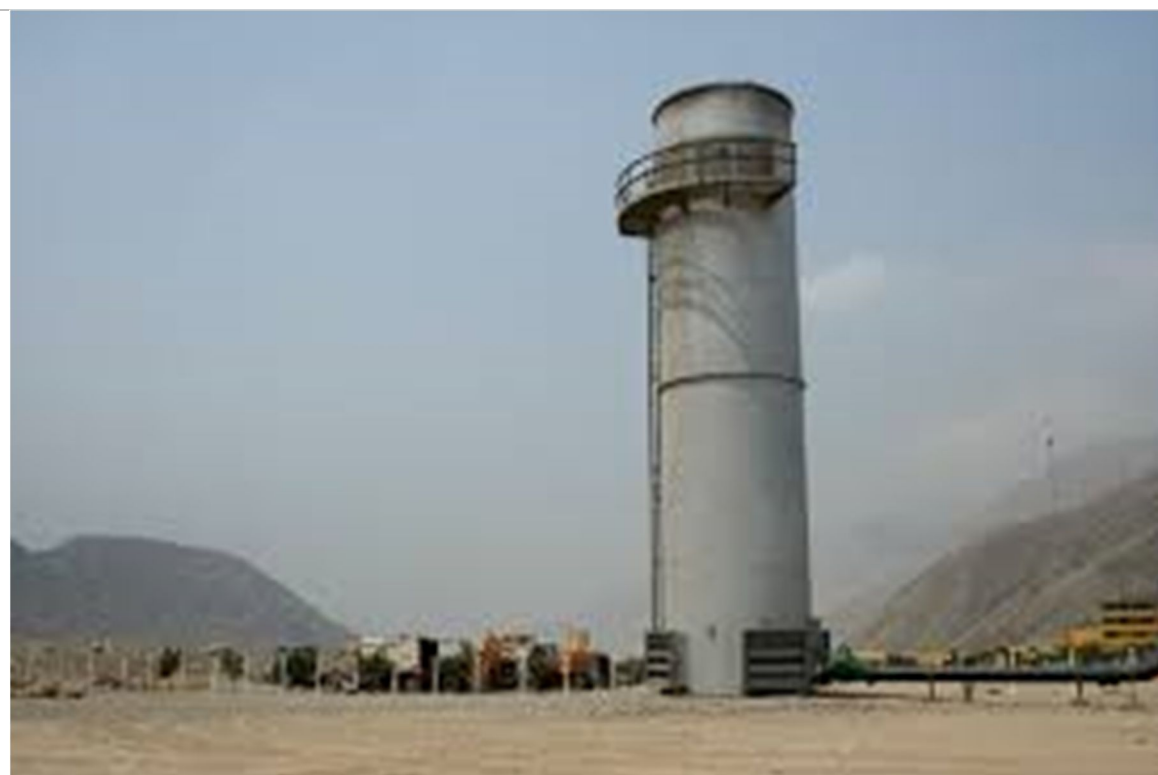
Queimador de biogás para geração de energia elétrica a partir do lixo
