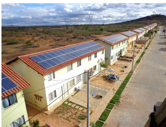
Condominio con paneles solares.
