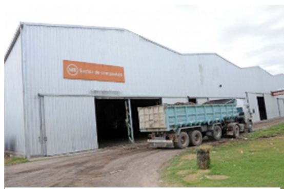
Nave de tratamiento de orgánicos.
