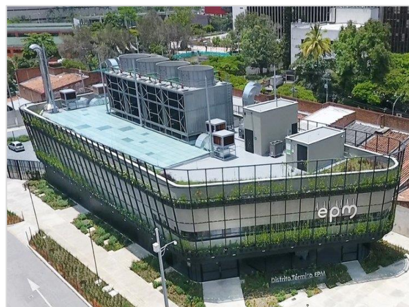
Fotografía aérea del edificio/
