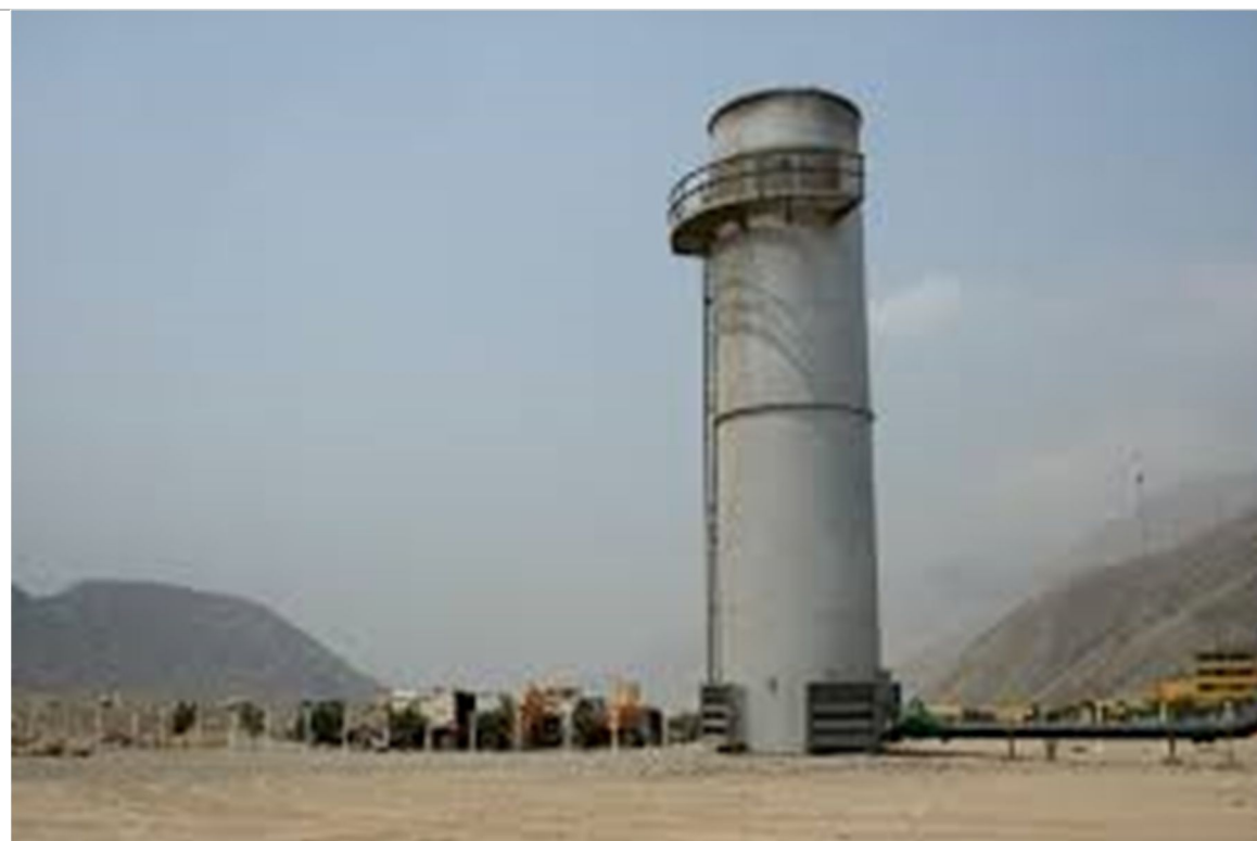
Quemador de biogás para la generación de energía eléctrica a partir de la basura
