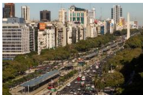
Vista del Centro de Tránsito de la Av. 9 de Julio.
