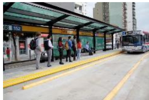
Parada sobre la calzada central y carril exclusivo para las unidades del transporte público de pasajeros.
