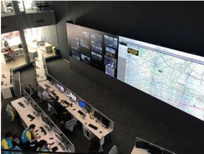
Videowall com informações em tempo real do sistema de sinalização de trânsito. Fonte: Revista Vial
