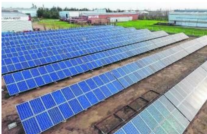
Instalação de piso solar instalada no parque industrial de Armstrong.
