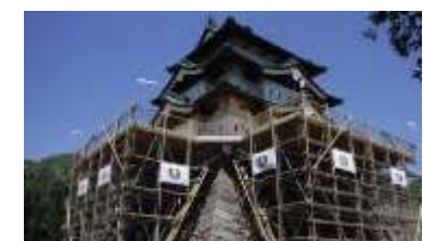
【 Ishigaki Repair Construction 】
